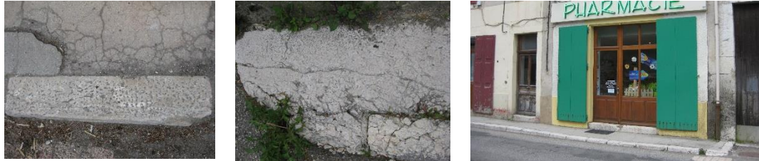
Seuils en pierre calcaire et ciment
