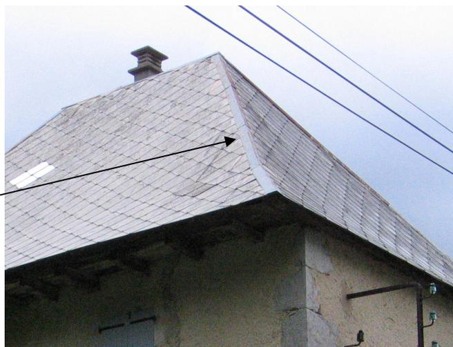
Sur les toits en tuiles écailles, les arêtes sont couvertes de tuiles légèrement arrondies.
