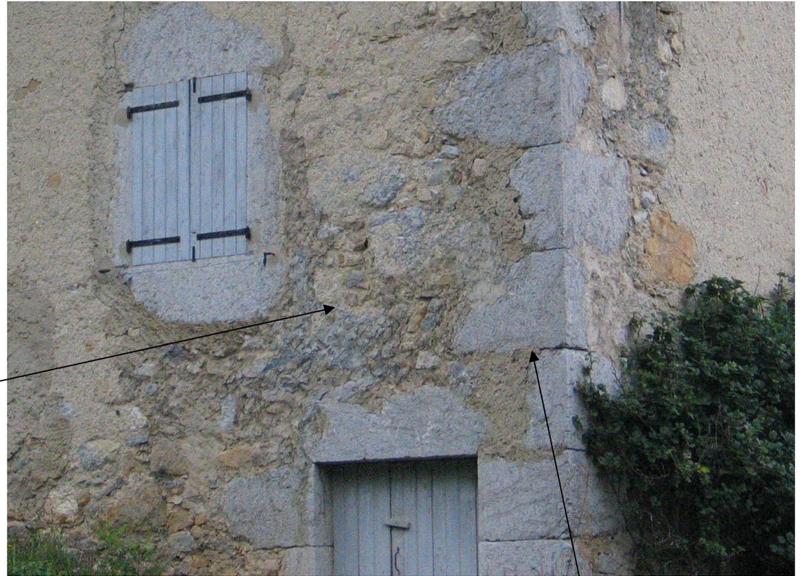
Les pierres apparentes se trouvent sur le même plan que l'enduit.
