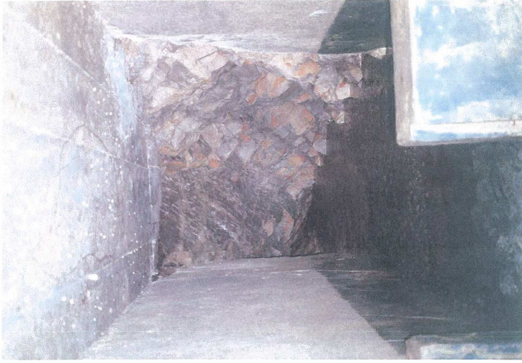
VUE DE L'INTERIEUR DU CAPTAGE
