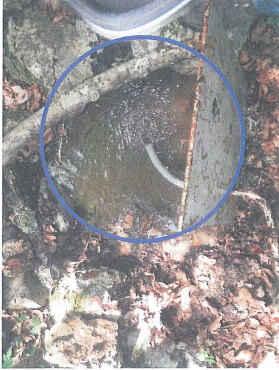
REGARD DE JONCTION DU RESEAU AGRICOLE * DEUX ARRIVÉES: DEPUIS OUVRAGE PUBLIC ET DEPUIS CAPTAGE PRIVE (A VERIFIER) * UN DEPART VERS ABREUVOIRS
