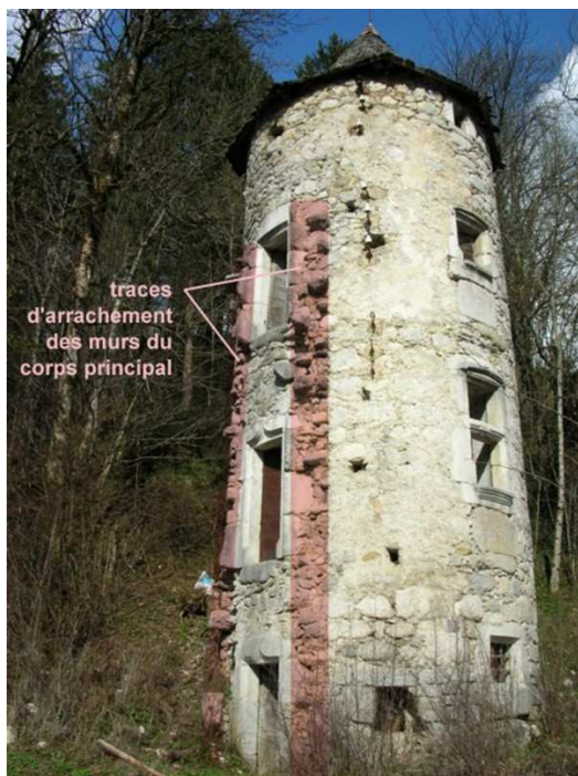
Traces d'arrachement des murs – Tour de l'Infernet
