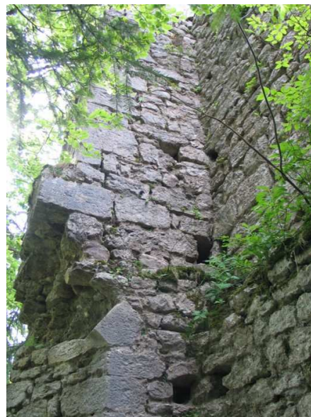
Élévation intérieure sud du donjon – Château des Teppaz
