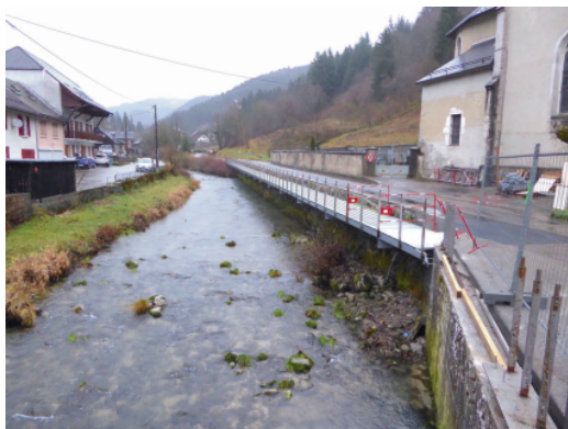
La passerelle en construction le long du Cozon
