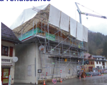
La toiture de La Poste en travaux
