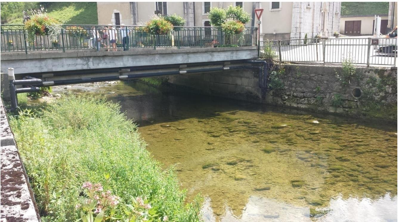
*Figure 26 : Réseaux en encorbellement, au dessus du pont communale*
